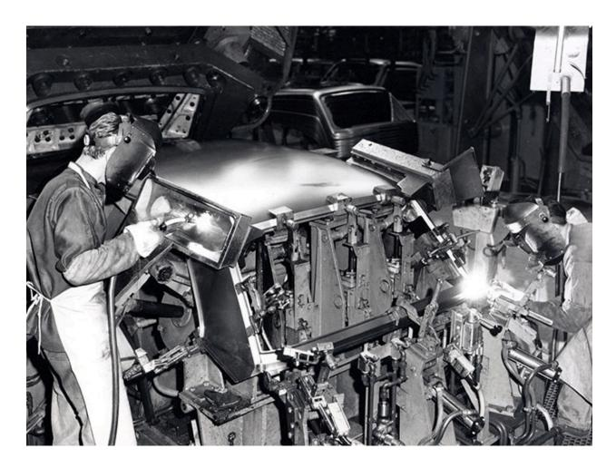
Automobile : assemblage par soudure de la caisse d'une automobile Peugeot, 30 septembre 1965.
