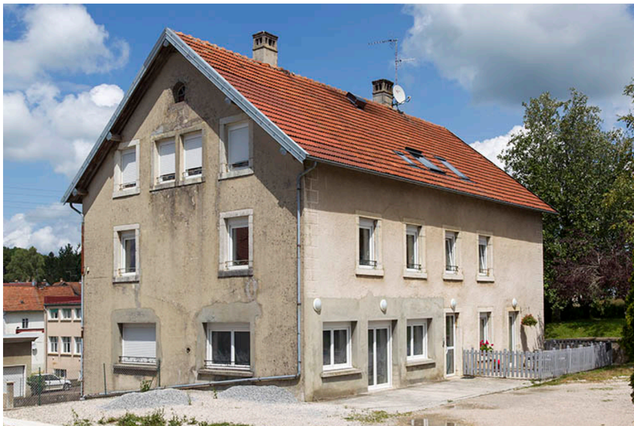
Façades postérieure et latérale droite.
