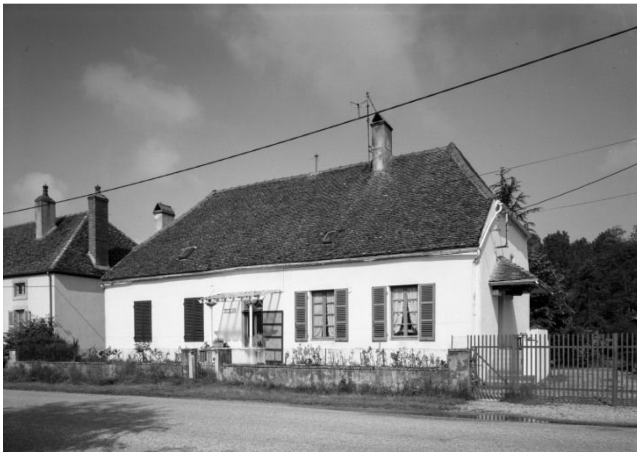
Vue d'ensemble d'une maison (cad. 1981, sect. B2, parc. 436).
