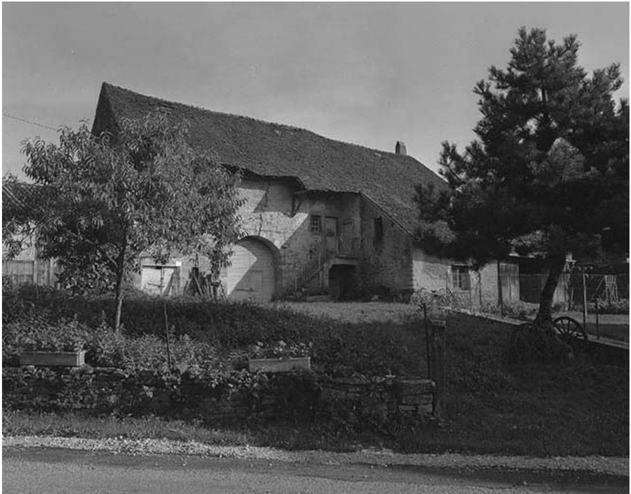
Façade antérieure vue générale de trois quarts.
