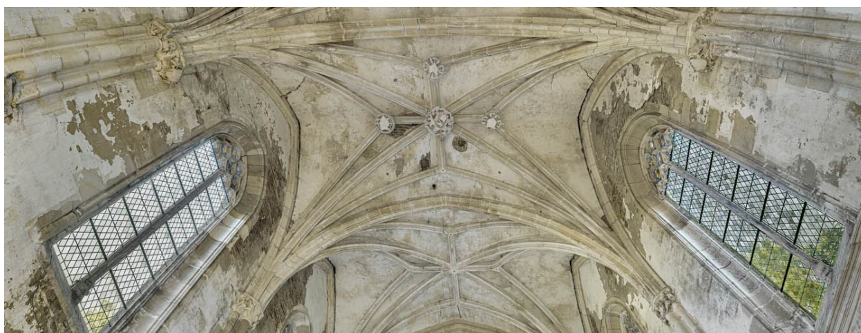
Intérieur de la chapelle : voûtes de la nef.
