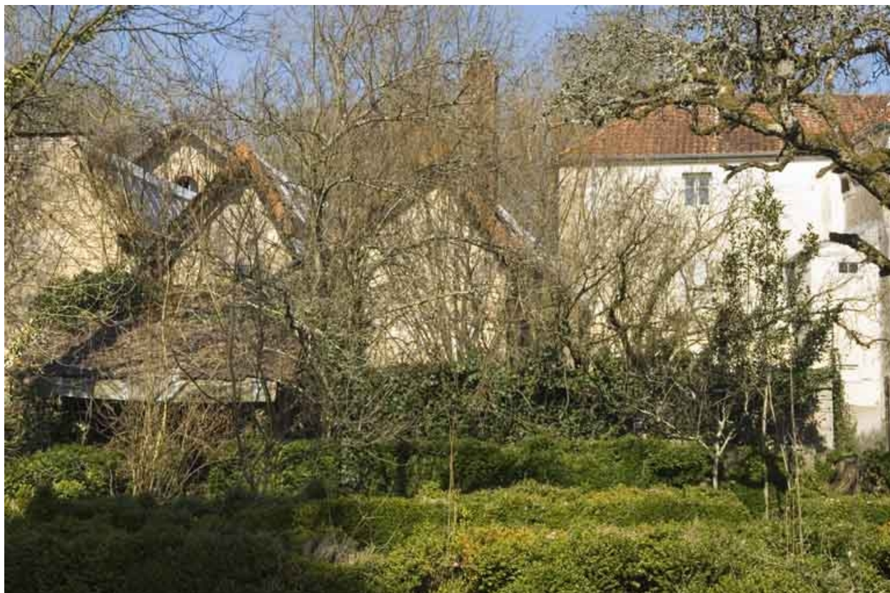
Atelier de fabrication et logement depuis l'ouest.
