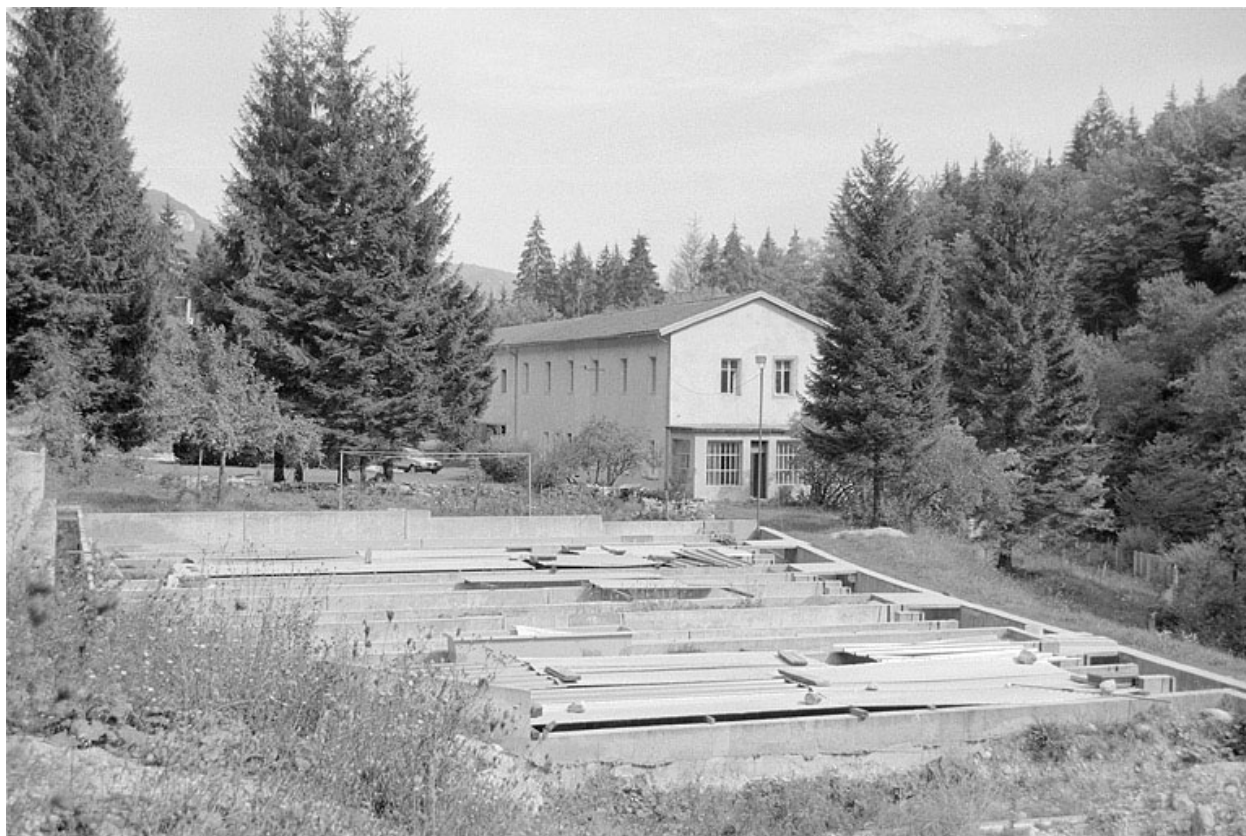
Bassins et bâtiment, depuis le sud-ouest.
