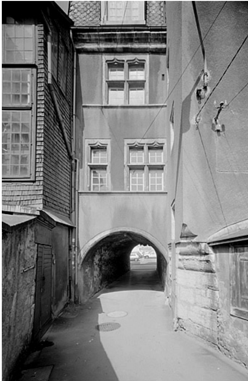
Façade sur le passage de la Fleur.
