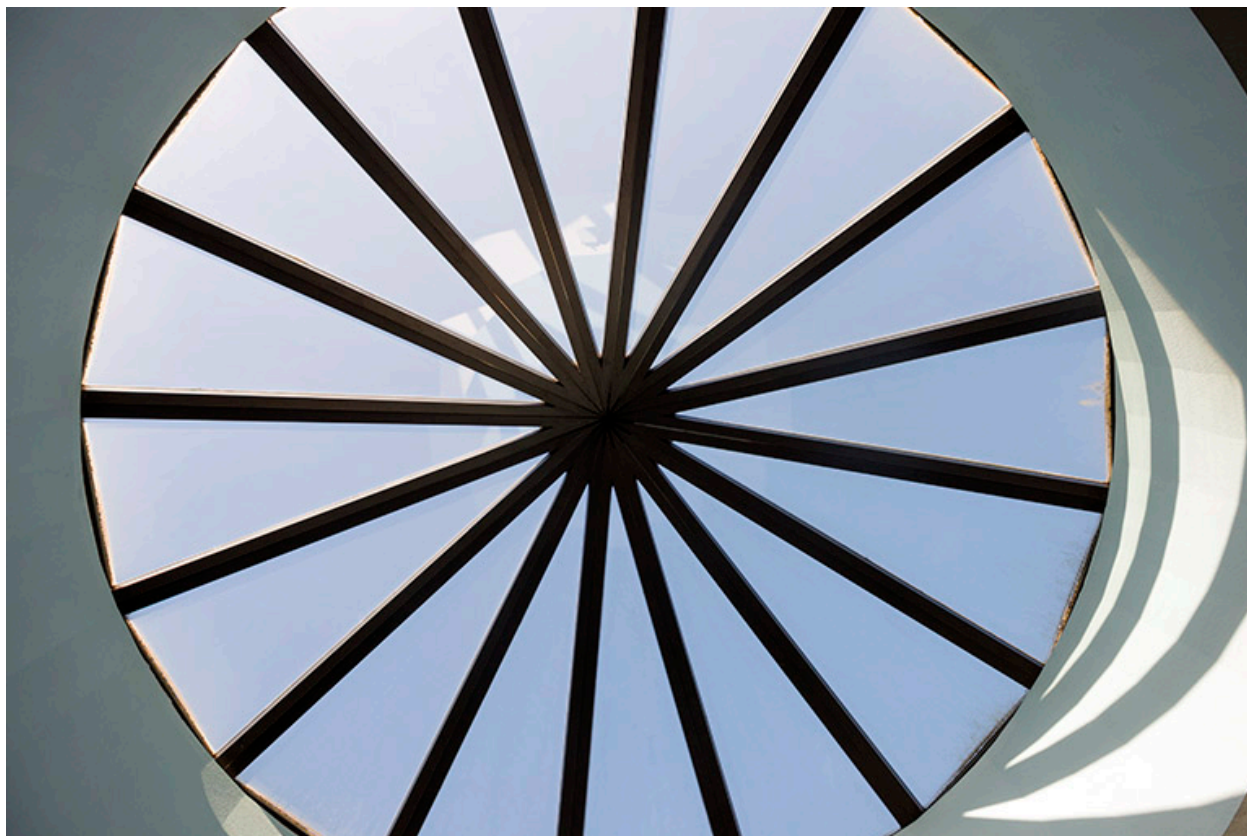
Détail intérieur de l'oculus zénithal du hall.
