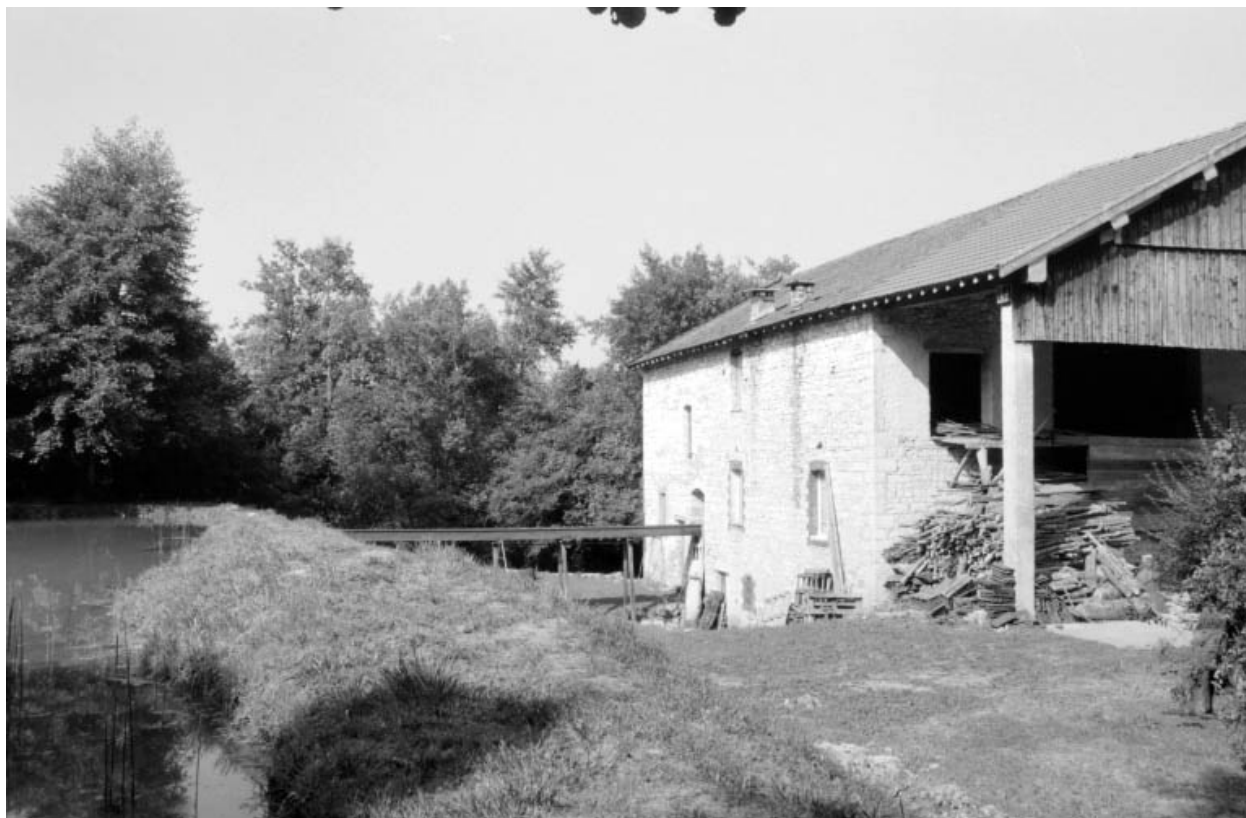
Façade postérieure et conduite d'amenée de la roue.
