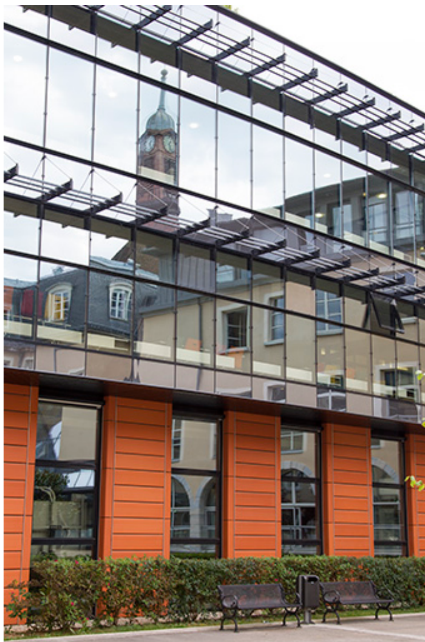
Aile Est : détail des structures.
