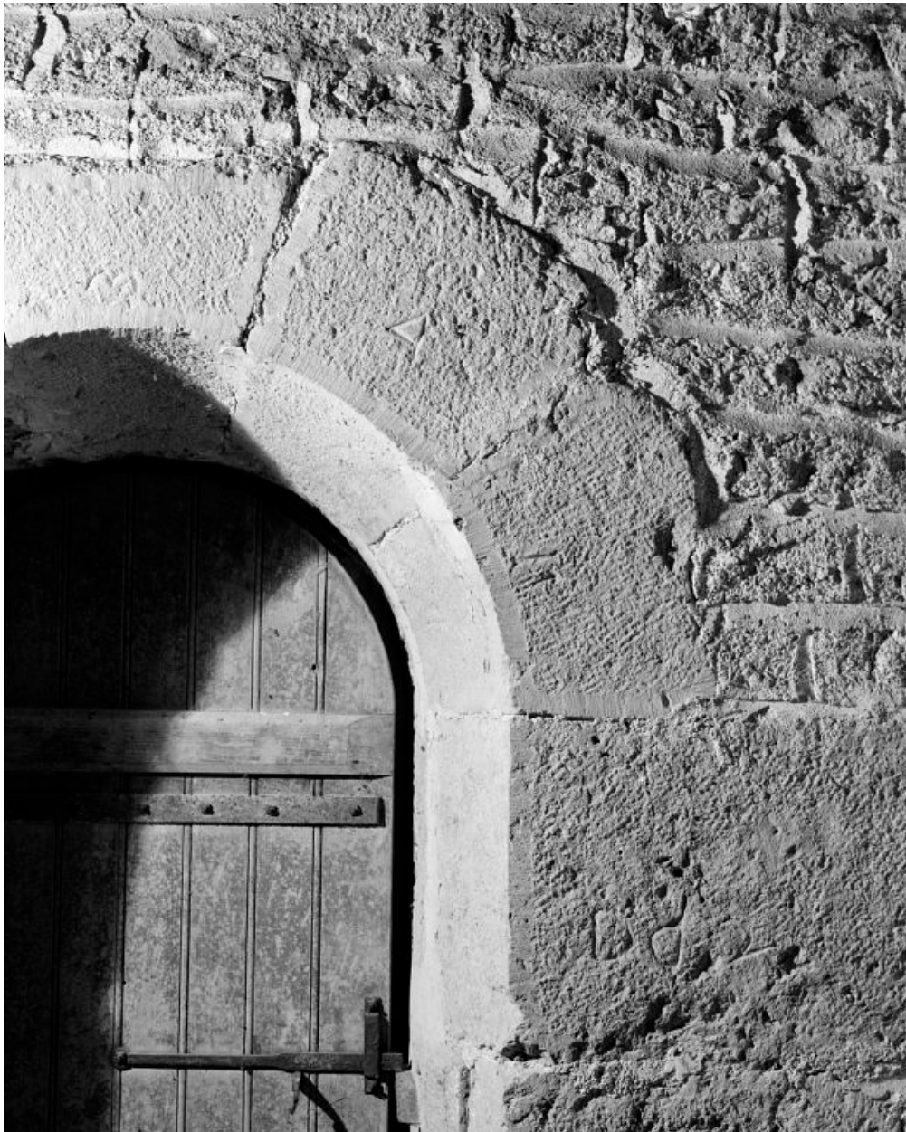
Clocher, 2e niveau : détail de la fenêtre gauche (transformée en porte).
