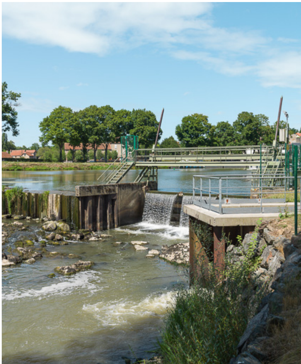
Vue du barrage.
