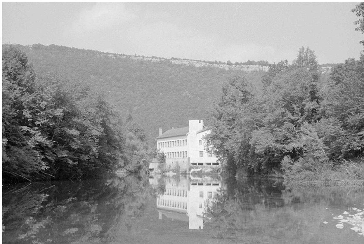
Vue d'ensemble, depuis le sud-est (amont).
