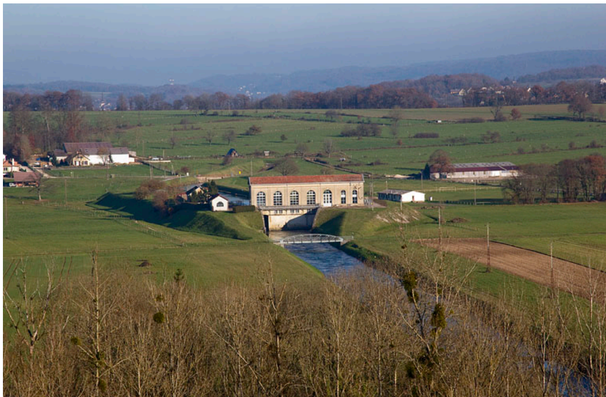
Centrale de la Prétière : vue d'ensemble depuis l'aval.
