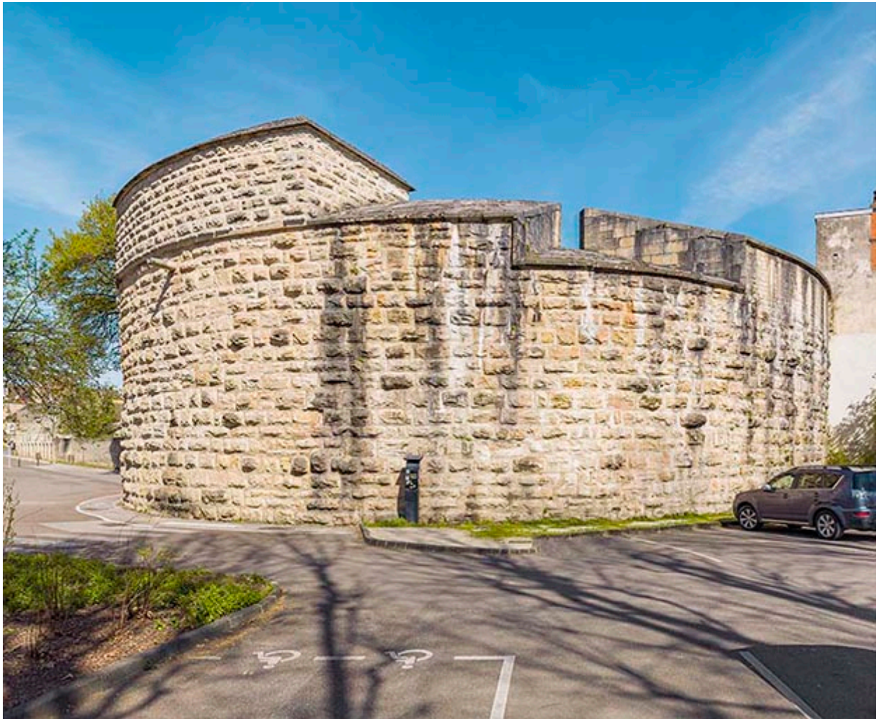
La tour et son parapet crénelé.
