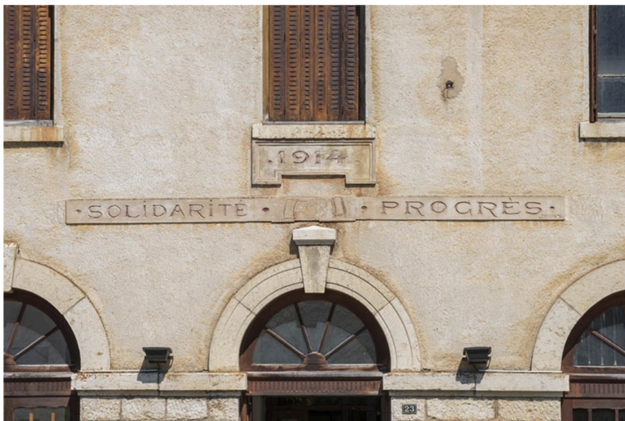
Détail du fronton de la façade.
