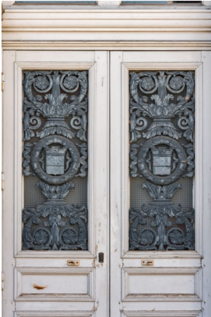
Façade antérieure : décor métallique d'une porte.
