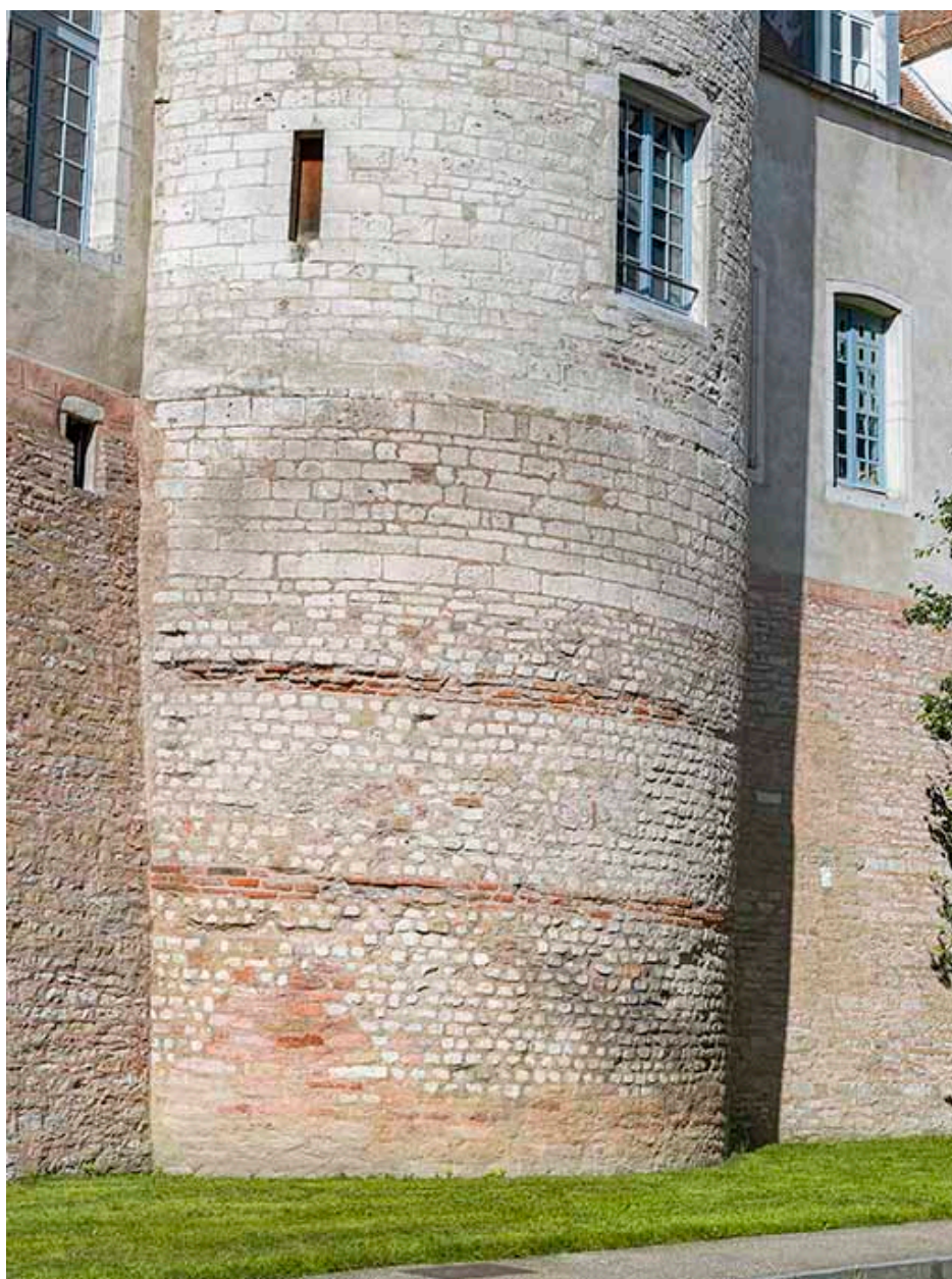
Détail de la maçonnerie, tour de l'Evêché.
