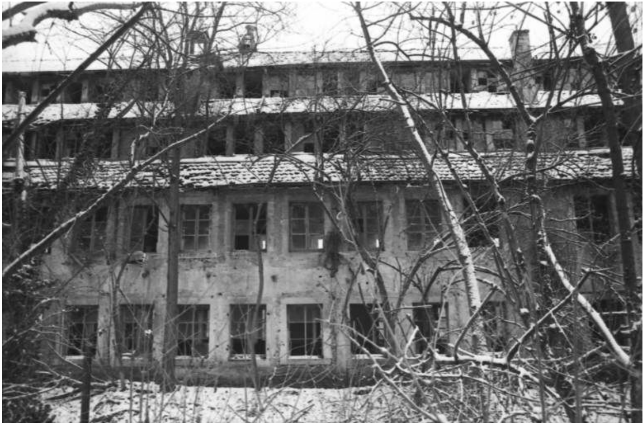
Façade occidentale de l'atelier d'horlogerie en 1979.
