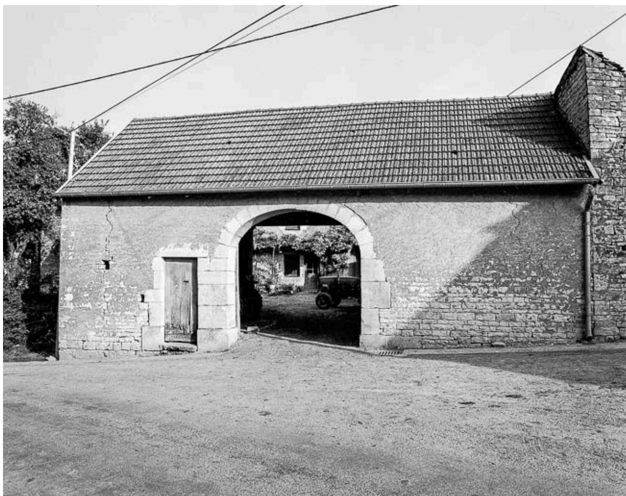
Vantoux-et-Longeville : ferme, bâtiment d'entrée sur cour.
