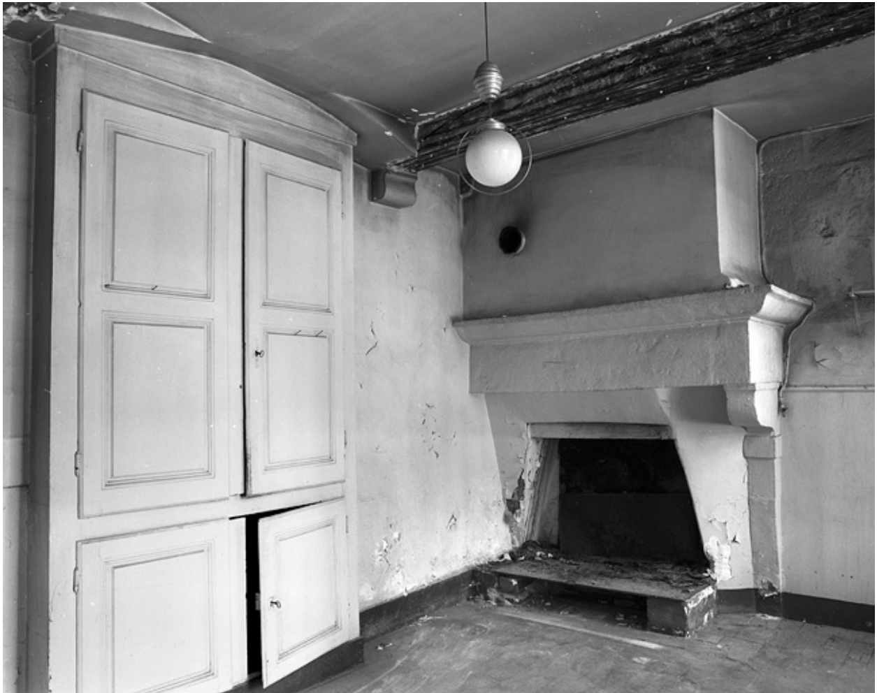
Communs : intérieur de la cuisine.
