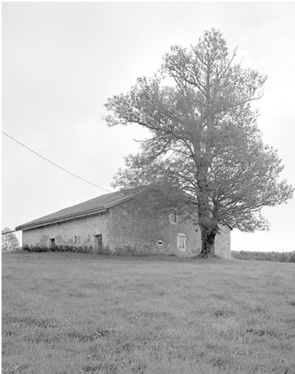
Face sud-ouest et façade postérieure.
