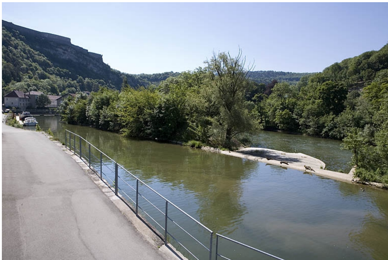
L'extrémité du barrage et le déversoir de superficie.
