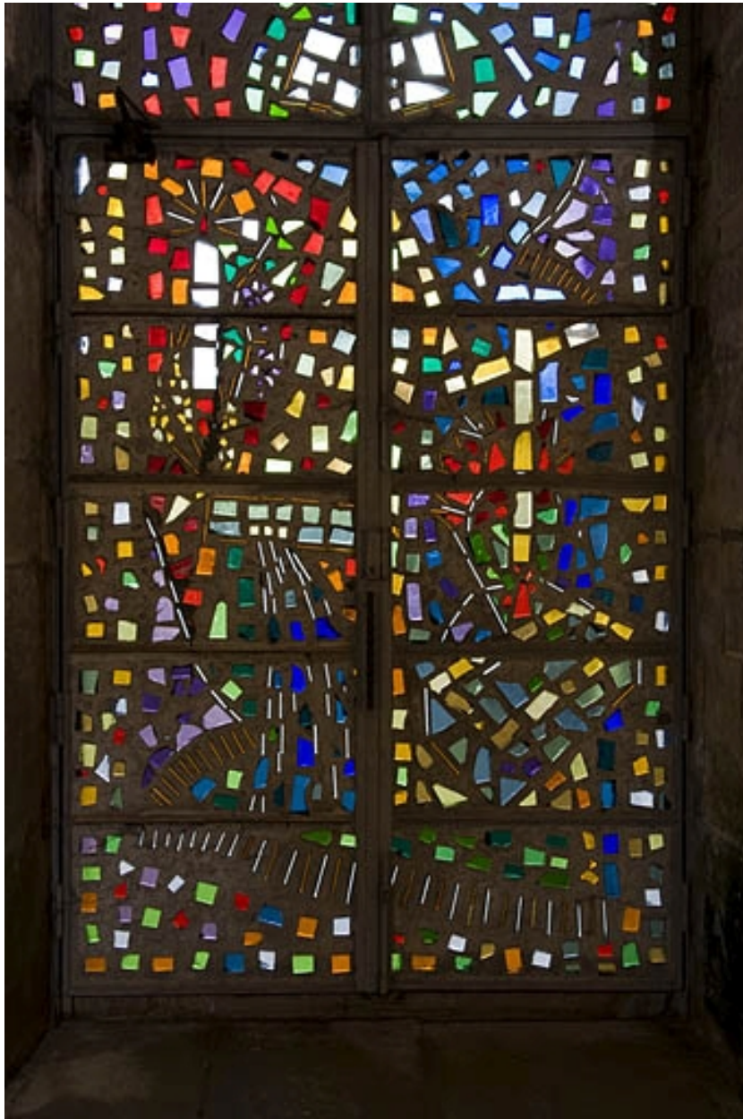
Vue générale rapprochée depuis l'intérieur.
