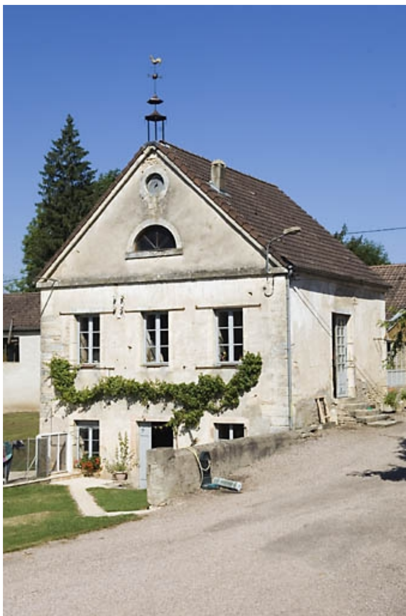
Bâtiment d'eau vu de trois quarts droite.
