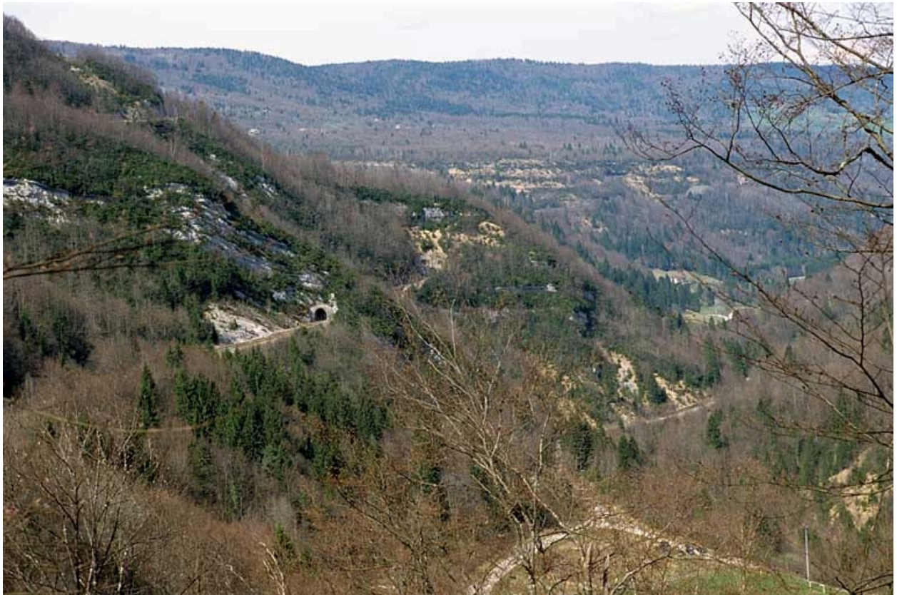
Vue d'ensemble des ouvrages et de la vallée de la Bienne, depuis le côté La Cluse (sud).
