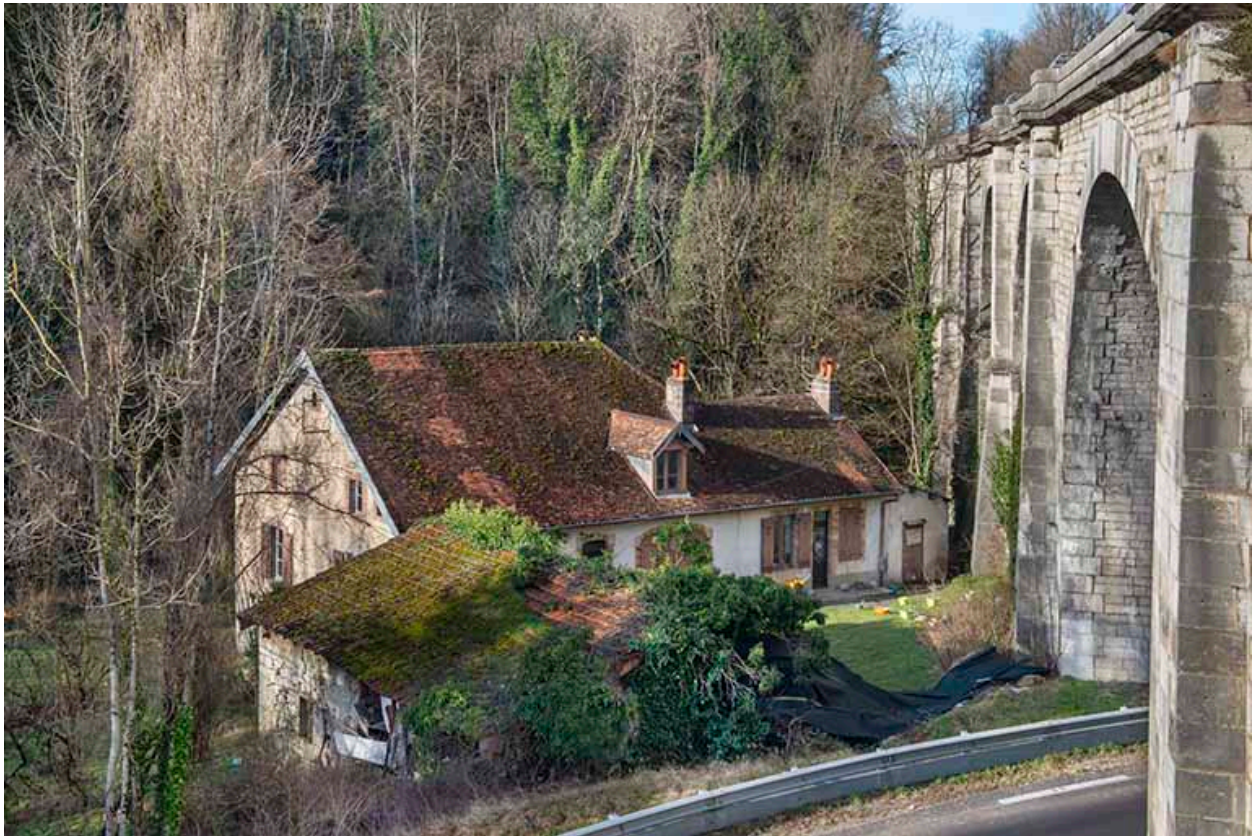
Virage et viaduc, vus de trois quarts.
