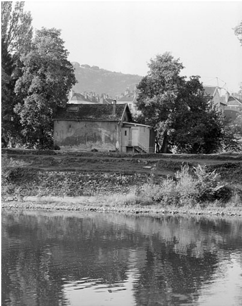
Façade antérieure en 2003, avant restauration.
