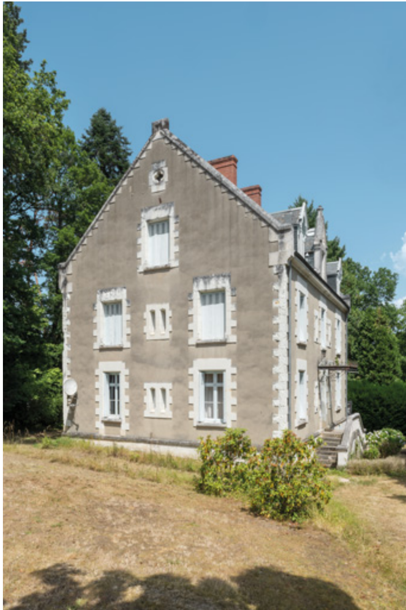
Mur pignon sud-ouest.
