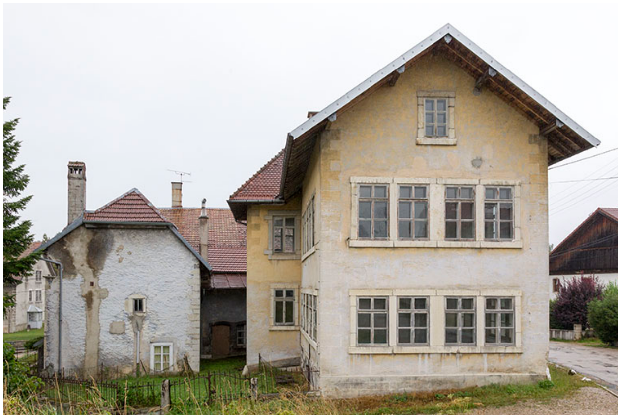
Usine : façade latérale gauche.
