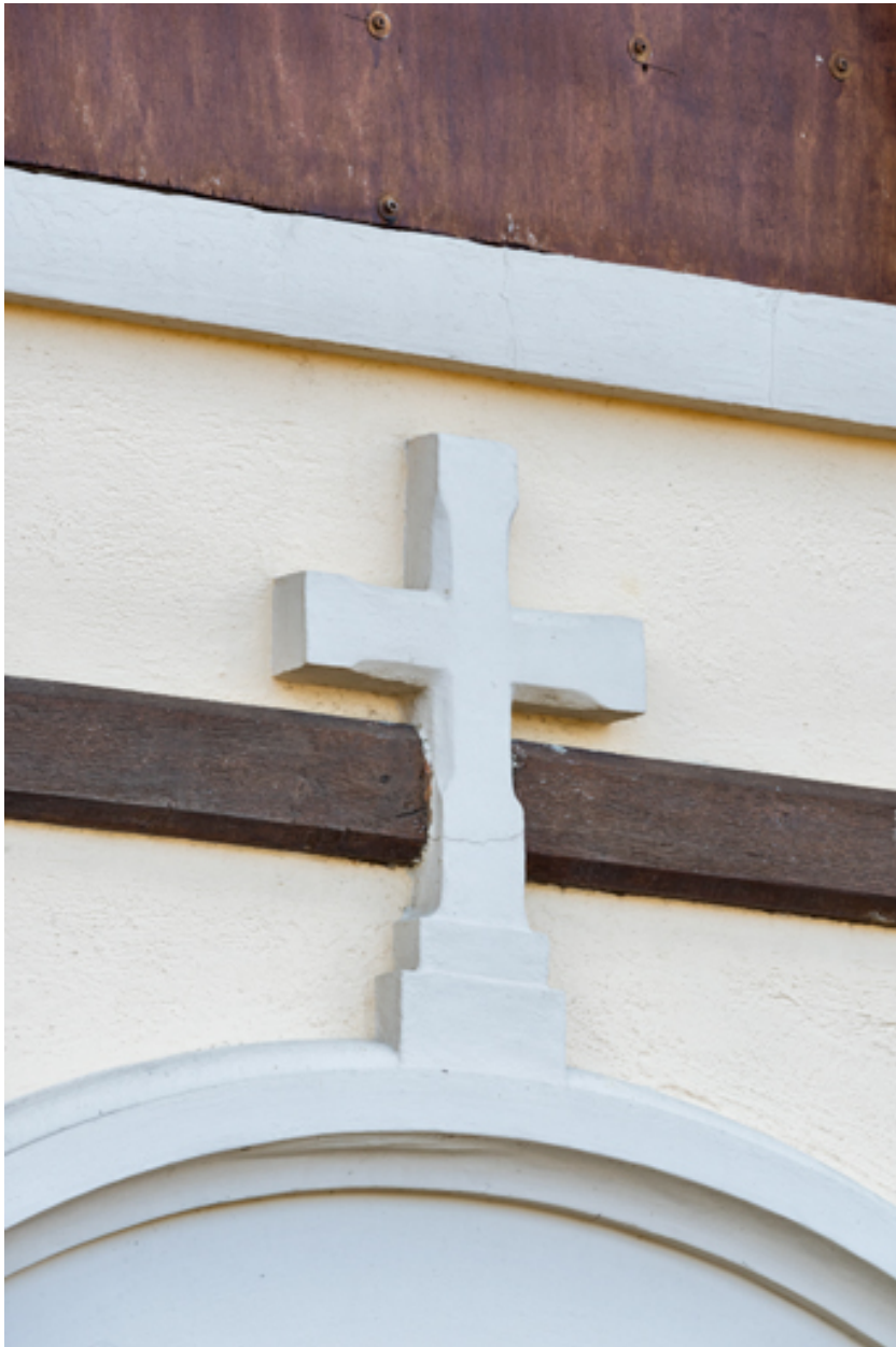
Détail de la croix surmontant la porte de la façade antérieure.
