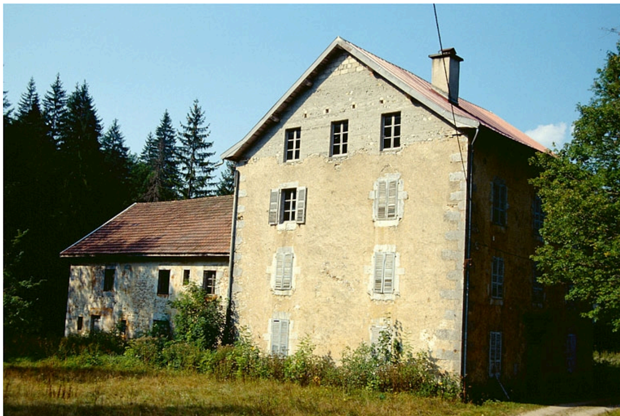
Logement et atelier de fabrication (B, C).
