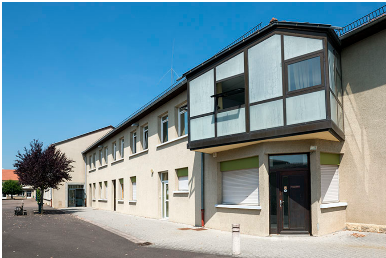
Angle sud-ouest à l'entrée de la cour.
