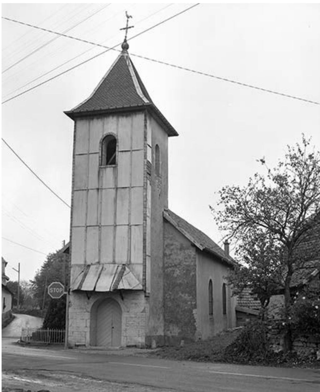
Façade antérieure et face latérale droite.
