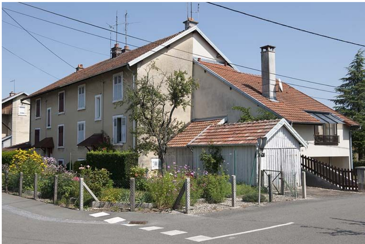
Habitation vue de trois quarts droite.
