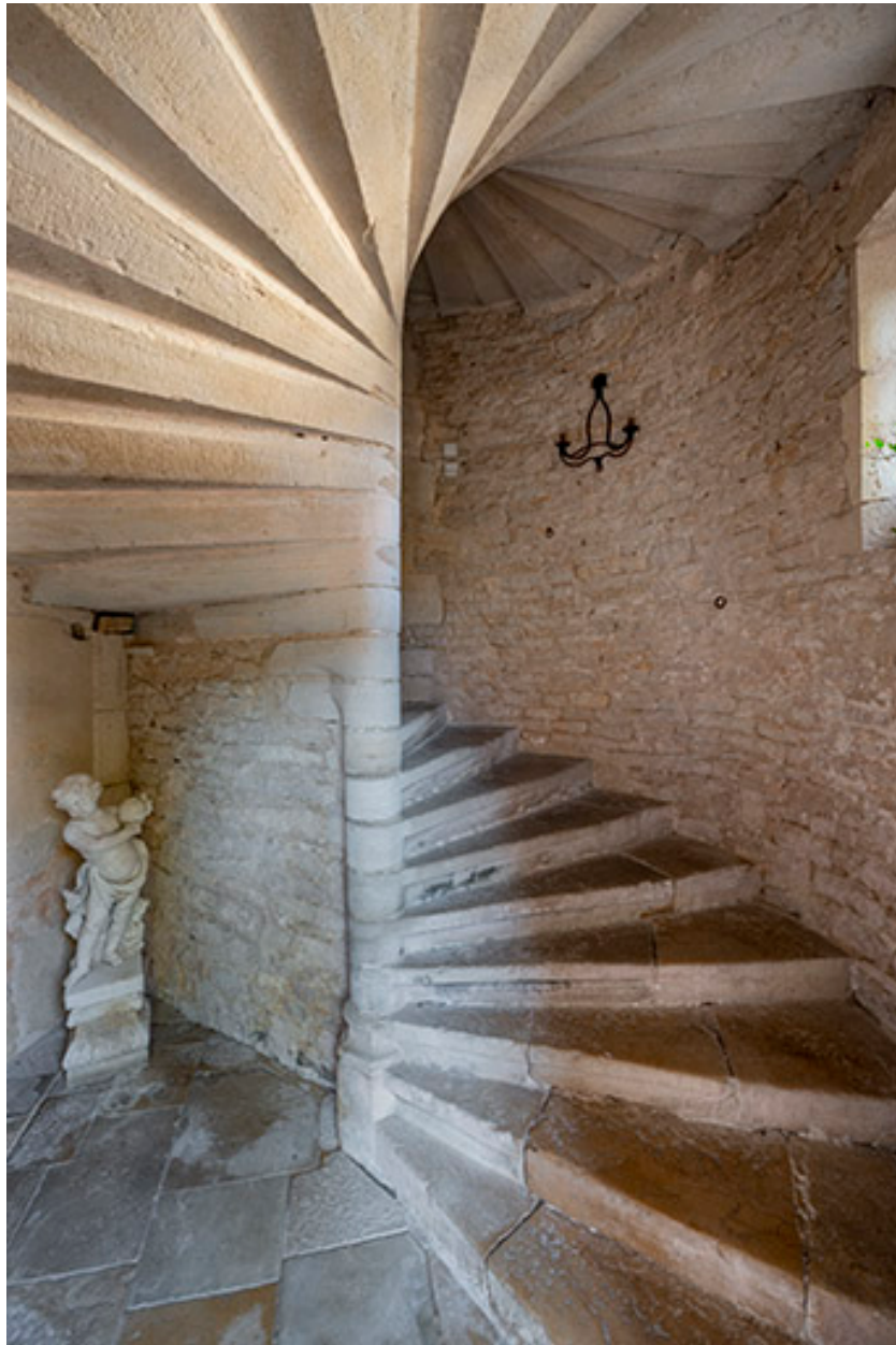
Escalier en vis, rez-de-chaussée.
