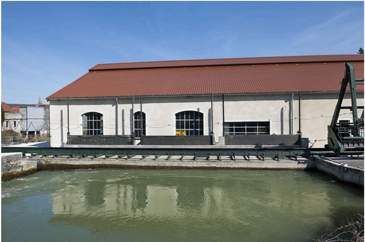
Bief d'aménée de la centrale hydroélectrique.
