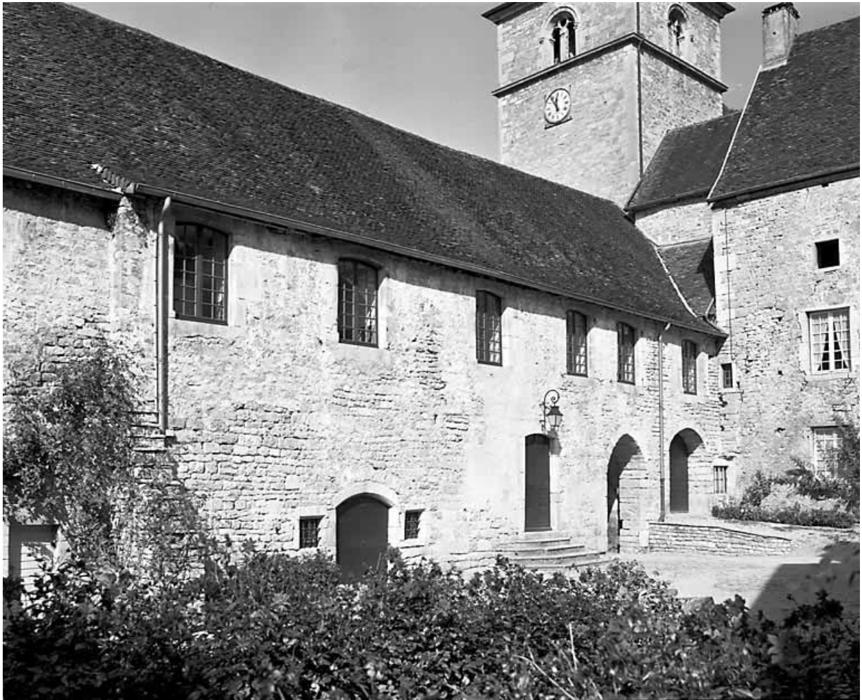
La cour des chanoines, face ouest.
