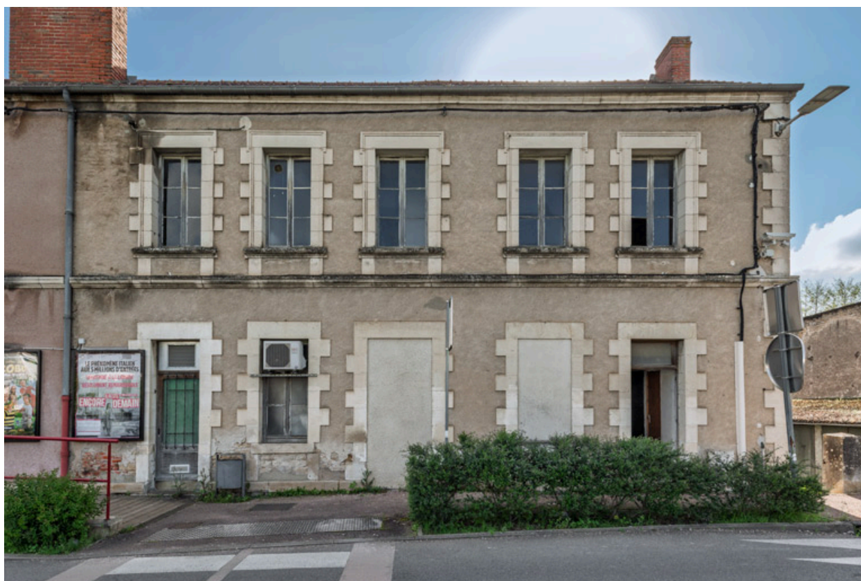
Façade antérieure, partie droite.
