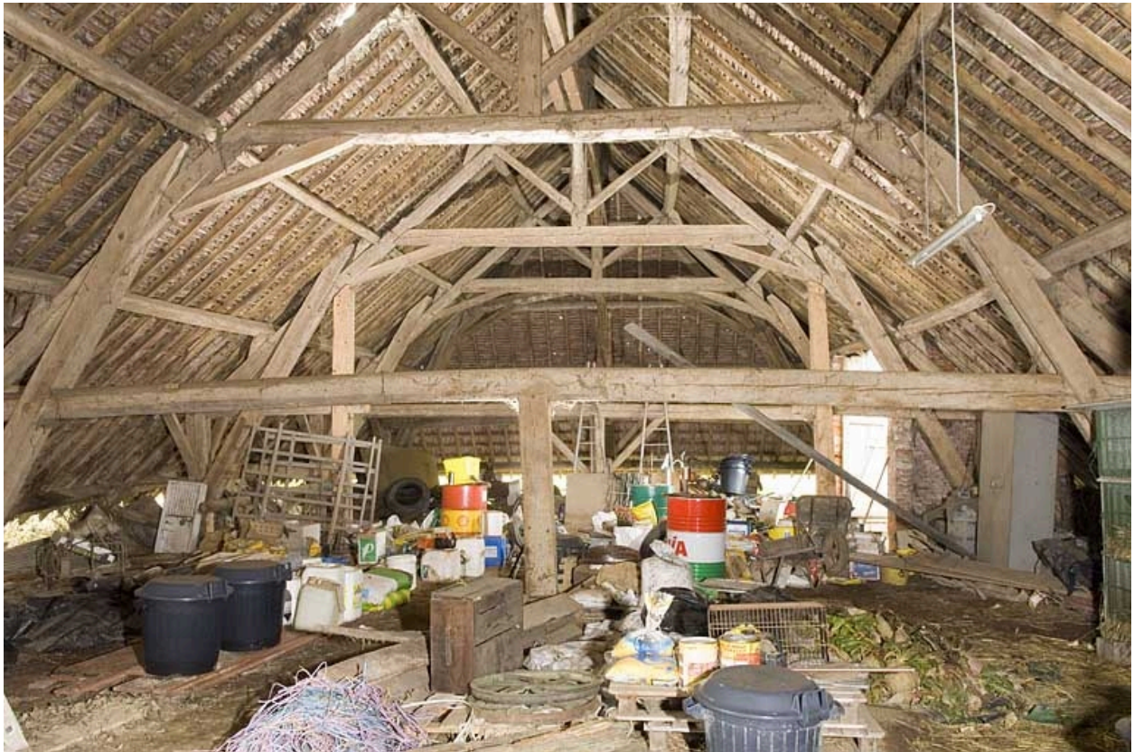
Tuilerie et briqueterie, Champtonnay : charpente du séchoir.
