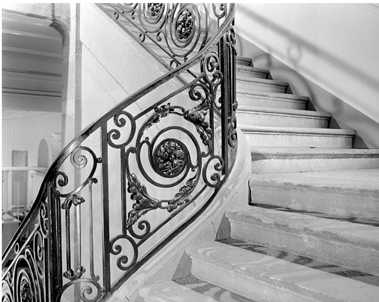
Détail, panneau de la montée gauche.
