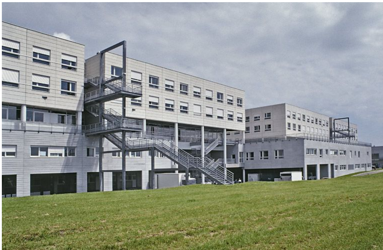
Façade postérieure, partie droite.
