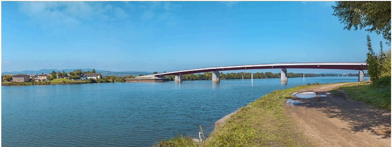
Vue d'ensemble du port et du pont d'Arciat, depuis la rive gauche de la Saône.
