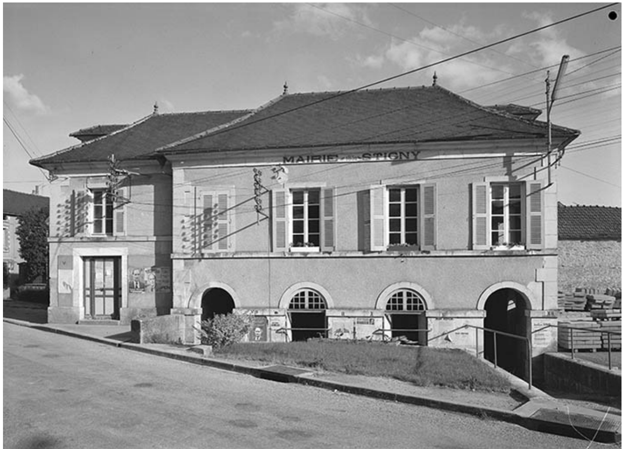
Façade principale avec lavoir en rez-de-chaussée.
