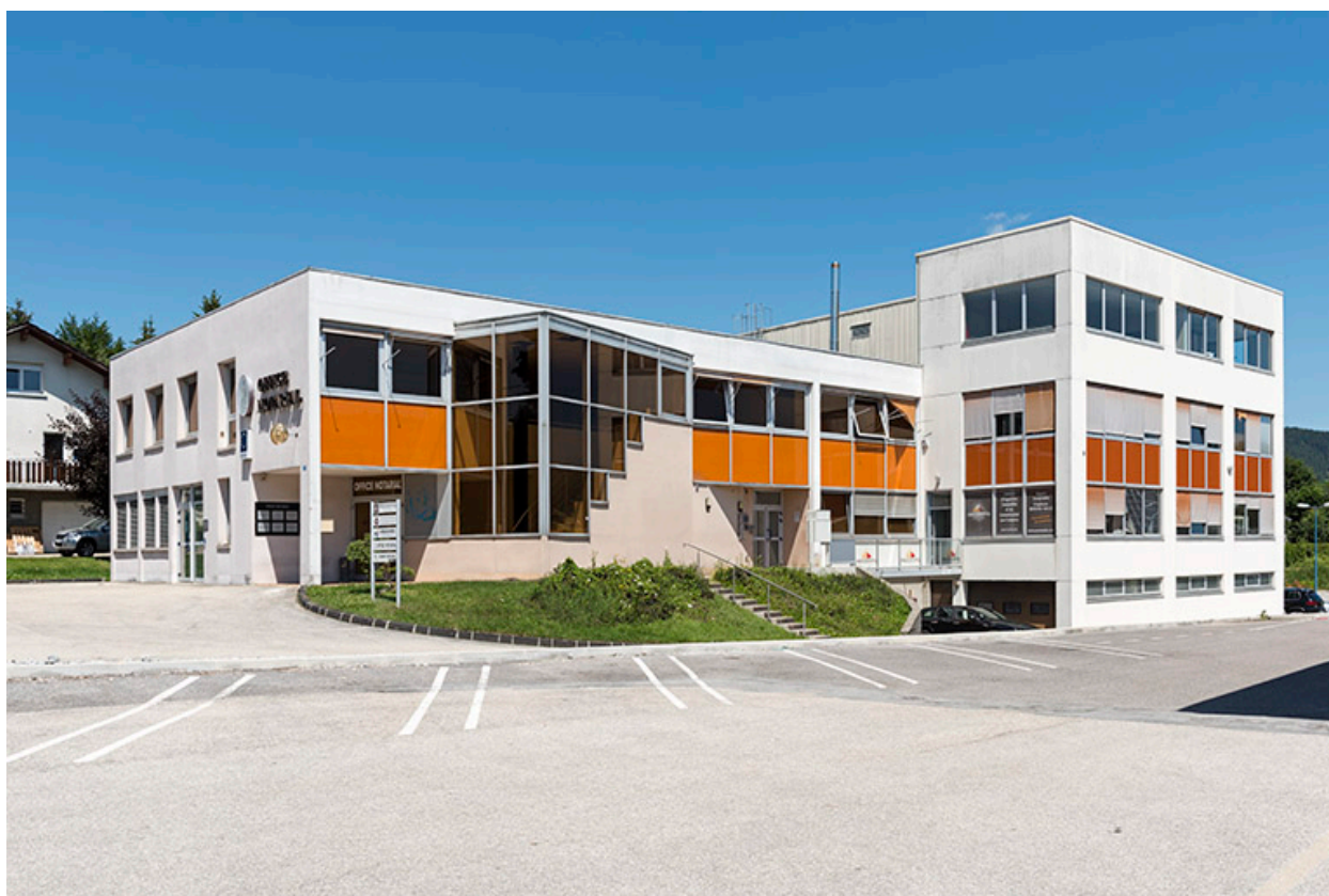
Usine d'horlogerie Charprier-Rième, 3 chemin des Pierres.
