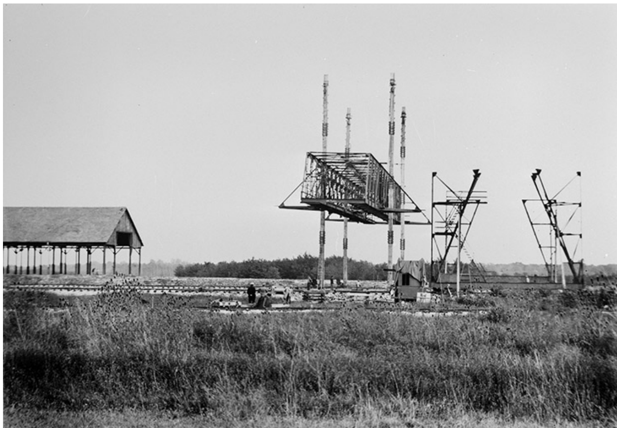
Montage du portique roulant du parc aux pièces, en 1928.
