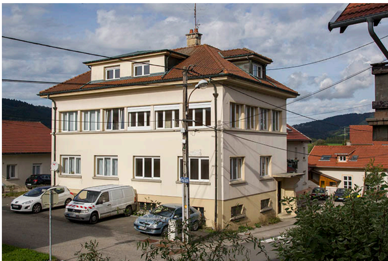
Usine : façades antérieure et latérale gauche.
