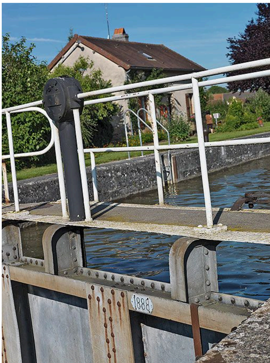
Détail des portes aval avec date portée 1888.
