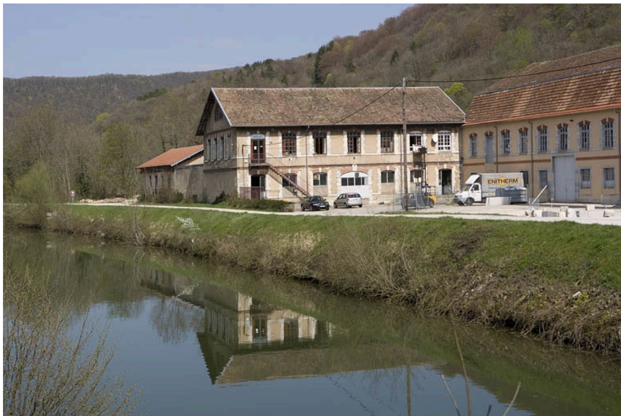
Vue du magasin de fournitures, depuis le chemin de halage.
